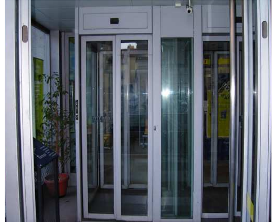
Fig. 13 - Ingresso principale con porte ad apertura automatica
