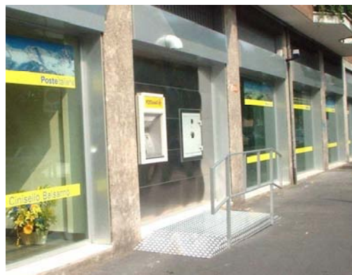
Fig. 22, 23 - Postamat accessibile per persone non vedenti (tastiera Braille) e per disabili su sedia a ruote (rampe e rispetto degli standard ADA-American with Disabilities Act).
