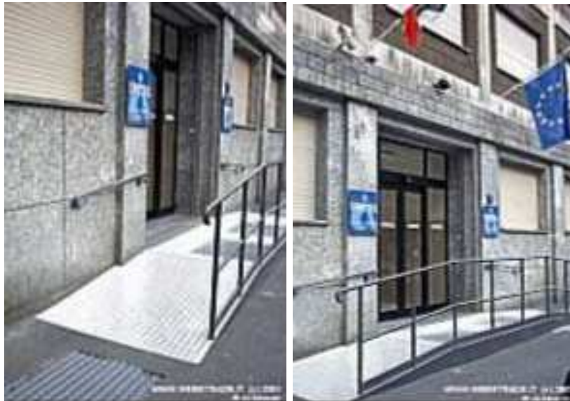
Fig 14, 15 - Eliminazione delle barriere architettoniche all'ingresso principale attraverso l'introduzione di rampe esterne per disabili su sedia a ruote, persone con difficoltà motorie o sensoriali, persone con i passeggini
