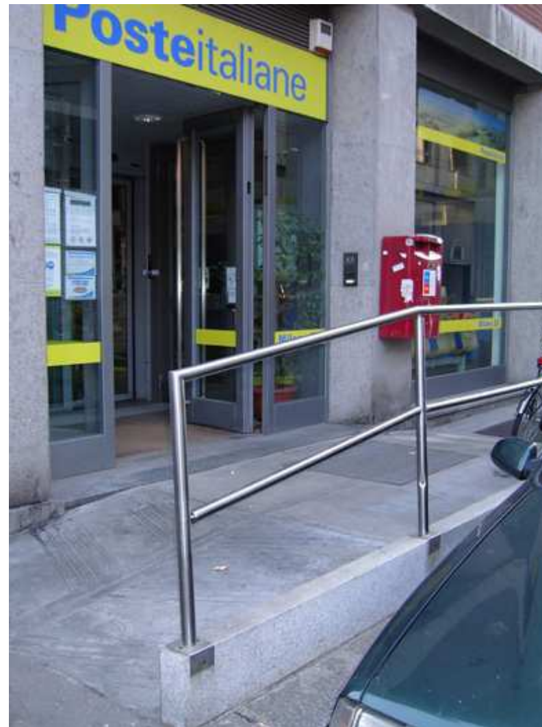
Fig. 6, 7 - Dettagli del raccordo stradale e della rampa per disabili all'esterno dell'ufficio postale
