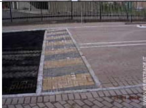
Rampe di salita in piattaforma colorate in bande giallo-nere di avvertimento
